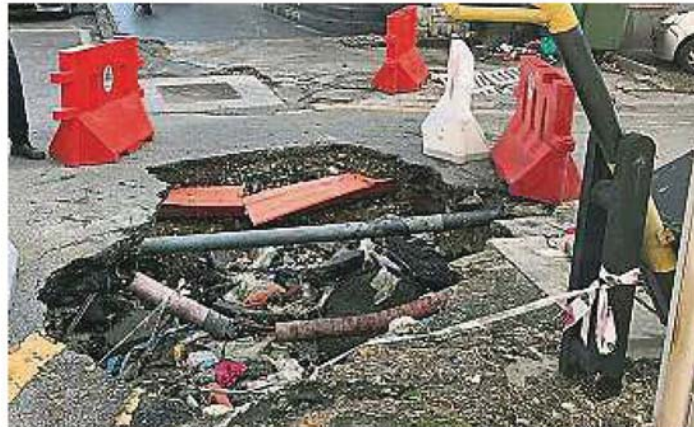
路洞露出水管与地下电缆。
